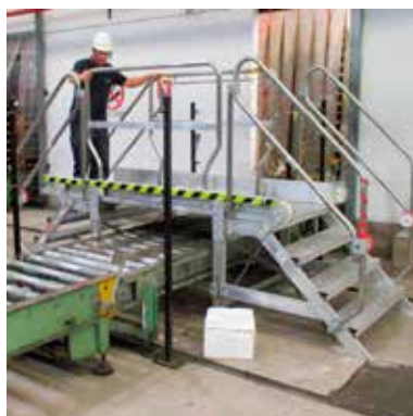
EM1108 Pasarela / Passadiço
